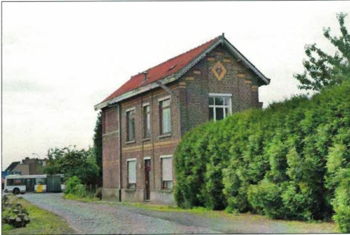
Wie goed kijkt ziet in het woonhuis nog de oude watertoren met kolenmagazijn: let op het linkergedeelte (ex-watertoren) waar geen ramen zitten. (foto Stefan Justens, 2008)
